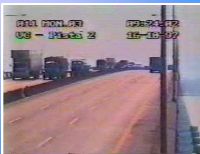
Ponte Rio – Niterói
